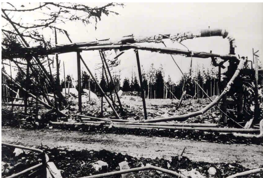
Die oberirdischen Dampfleitungen bei der Demontage nach der Sprengung des Kraftwerks.
