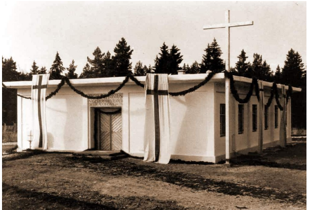
Die Bunkerkirche nach der Einweihung 1951
