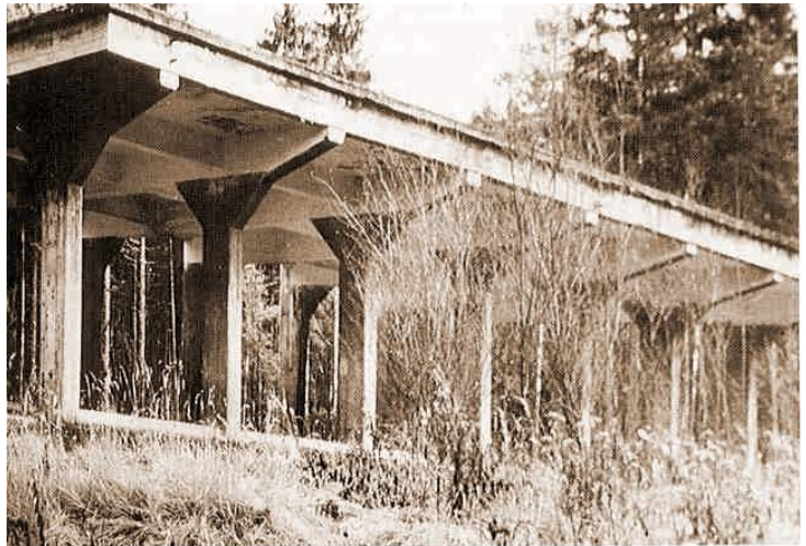
Verladerampe südlich des Rohi-Werkes
