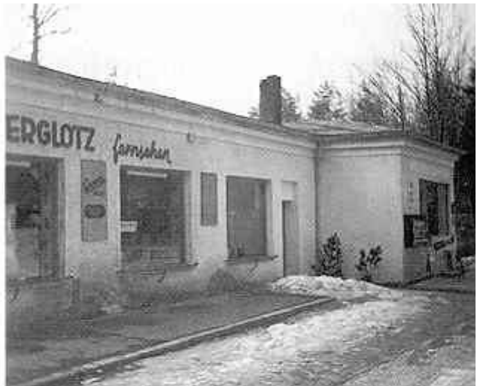
Das Gebäude mit dem Elektro- (links) und dem Lebensmittelgeschäft (rechts) vor der Aufstockung
