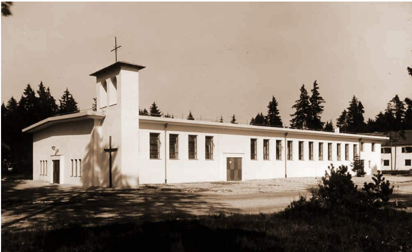
Die 1950 aus einer Werkshalle entstandene Gartenberger Notkirche
