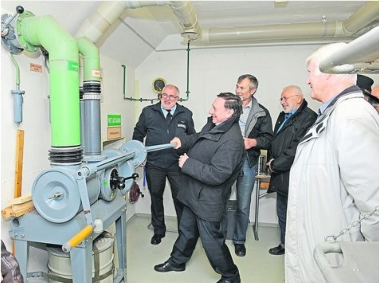
Abbildung 1: Kräftig kurbeln: Werner Sebb, stellvertretender Sprecher des Arbeitskreises Historisches Geretsried, legte bei einer Führung durch den ehemaligen Atomschutzbunker der Feuerwehrscheule an der noch funktionstüchtigen Kurbel der Belüftungsanlage Hand an. Heinrich Wolf (li.), Fachabteilungsleiter für Katastrophenschutz, erklärte, wie's geht.
