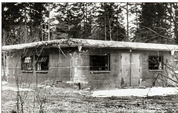
FoSa 091/503-001 2 leeres Pumpenhaus um 1950
