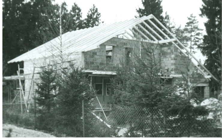
Das aufgestockte und erweiterte Gebäude im Rohbau 4 Foto W. Hildebrand
